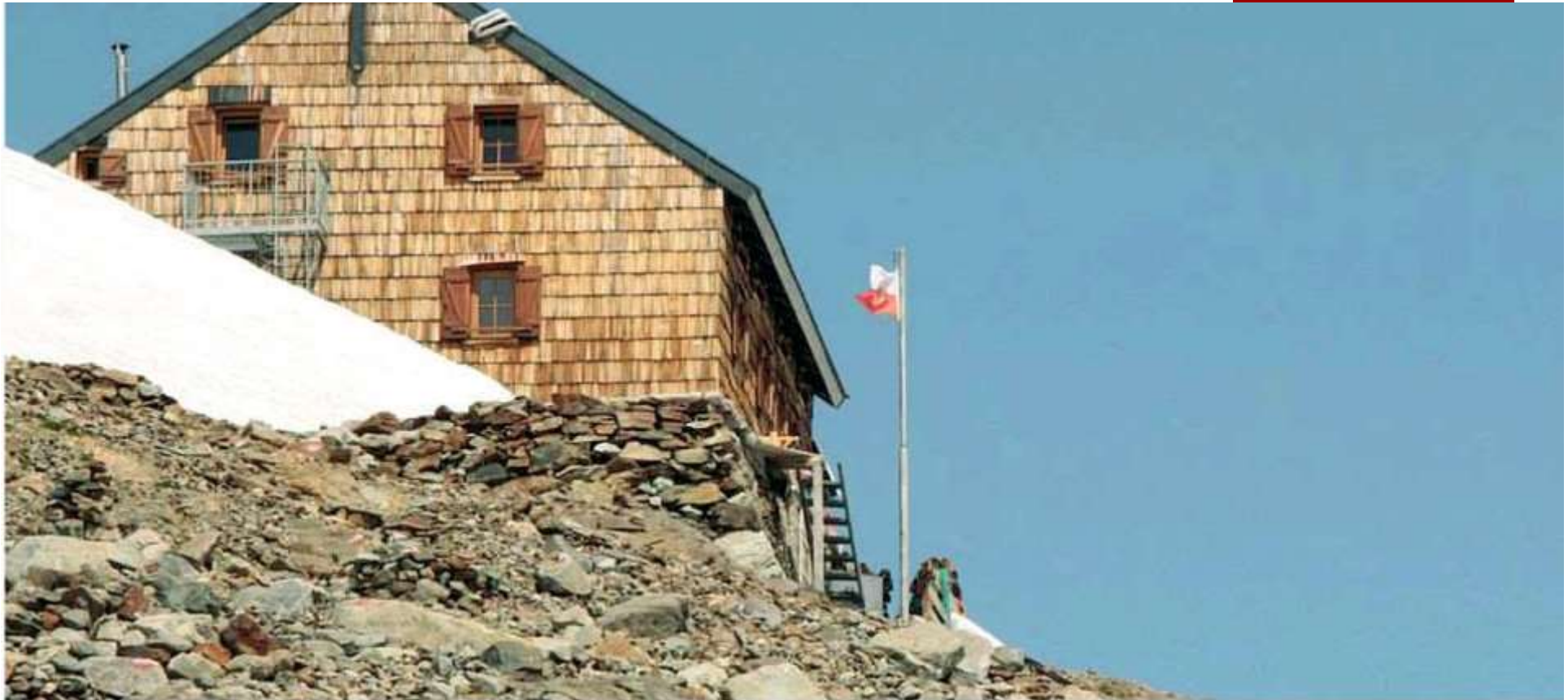
Avamposto Il rifugio Cima libera, 3.145 metri di quota in val Ridanna, è una delle strutture colpite dal ritiro dei ghiacci: di recente sono stati necessari interventi per consolidare le fondamenta
